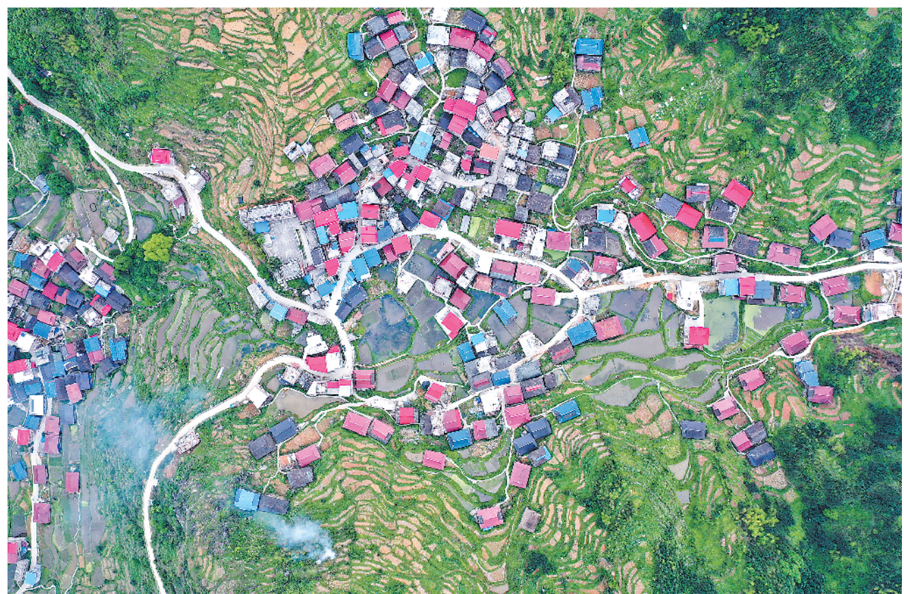
广西融水苗族自治县同瑶瑶族乡位于大山深处，全乡“九山半水半分田”，交通基础设施一度十分落后。近年来，当地大力推进基础设施建设，实现108个屯全部通路、49个20户以上屯全部通水泥路，打通了脱贫攻坚“最后一公里”。图为5月12日无人机拍摄的同瑶瑶族乡大坪村通村公路。
