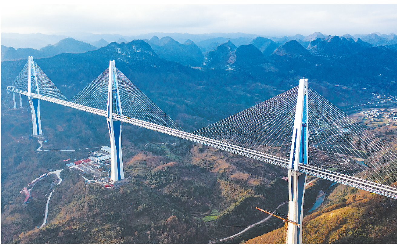
目前,贵州平塘至罗甸高速公路控制性工程平塘特大桥已经通过验收,将于近日全桥通车。平塘特大桥全长2135米,桥面宽30.2米,规划双向4车道,是一座三塔双索面叠合梁斜拉桥。图为12月29日拍摄的贵州平塘特大桥。 新华社发
