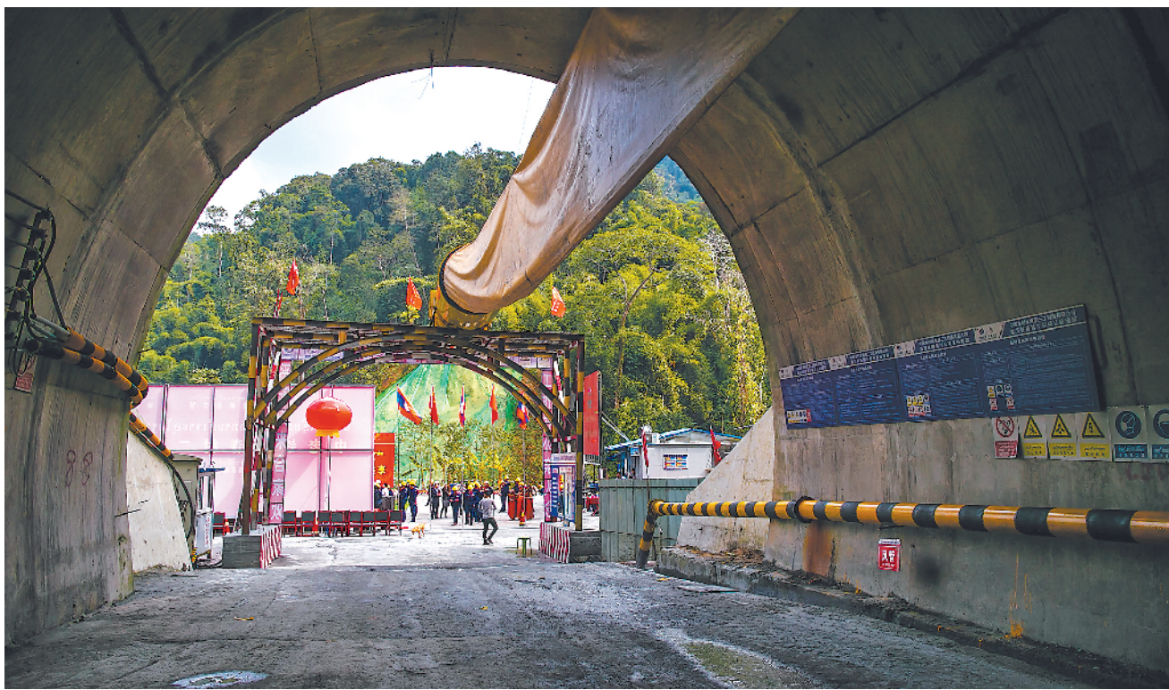
中方承建的中老铁路全线最长隧道森村二号隧道27日顺利贯通，比原计划工期提前7个月。这是12月27日在老挝琅勃拉邦省和万象省之间拍摄的森村二号隧道。
